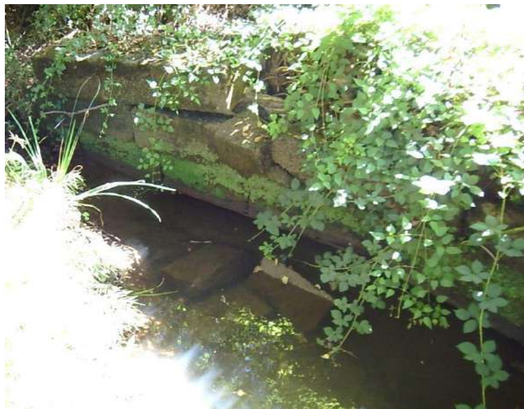
Fig. 6. Etat actuel de l'ouvrage de décharge amont
