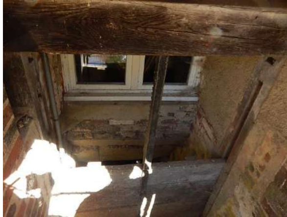
Fig. 3. Vue d'une vanne motrice
